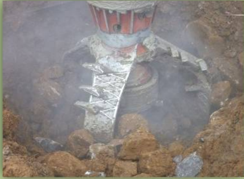
硬質地盤施工
