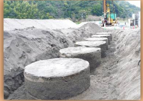
大口径施工(最大φ2.5m)
