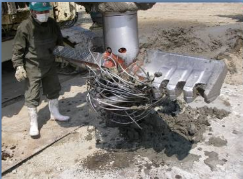
杭破碎同時施工
